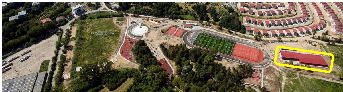
Vederea aeriană a clădirilor obiectivului (Baza sportivă Gheorgheni)
