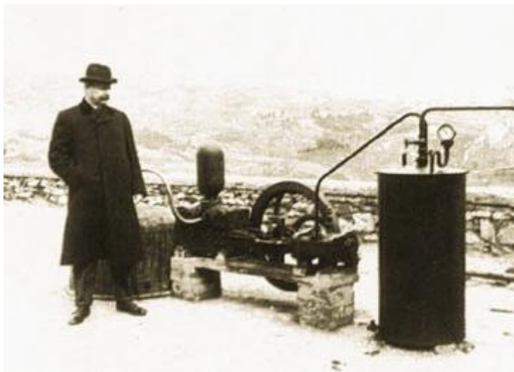
Prima instalație termoelectrică geotermală din lume (1904 - Larderello, Italia).
